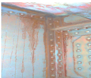
Apparition de la végétation, égradation et corrosion de la structure métallique
