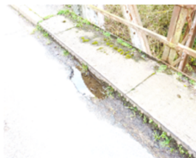
Apparition de la végétation, égradation et corrosion de la structure métallique
