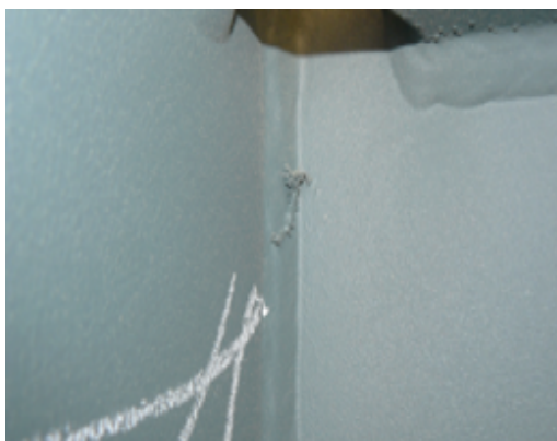
Incrustation de salissures dans le film de peinture humide
