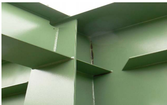
Brûlage du revêtement peinture / Soudage de raidisseurs.
