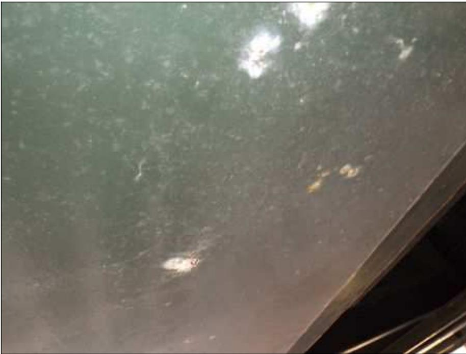
*Corrosion sur la sous-face de la semelle inférieure*
