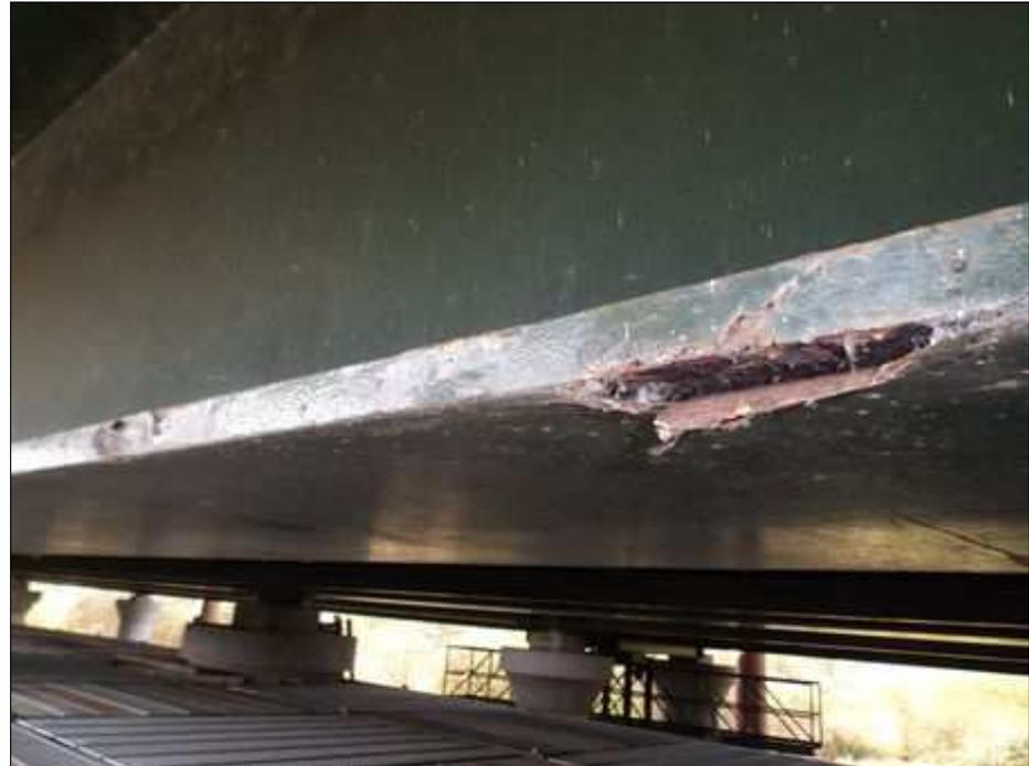
*Corrosion sur les chants des semelles des poutres principales*
